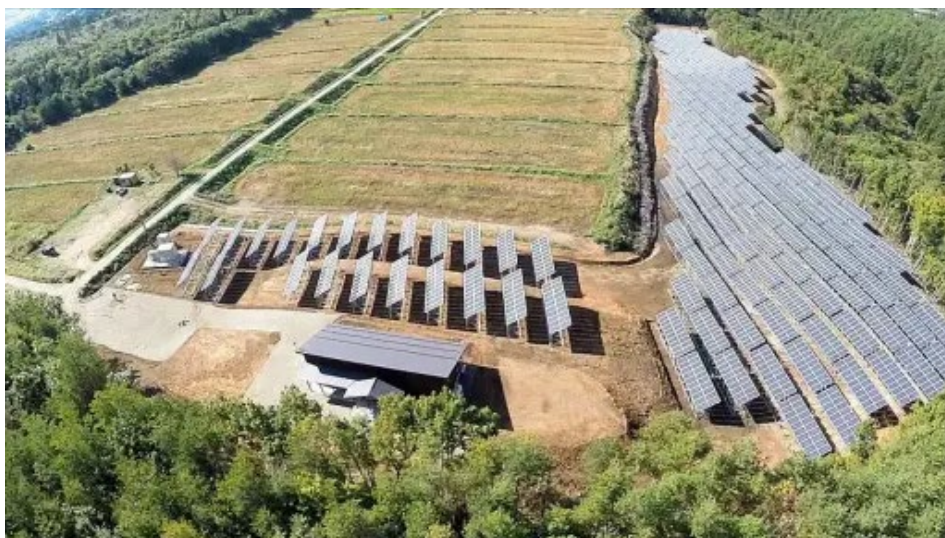
【画像 1-2】会津電力株式会社雄国太陽光発電所 (出典：会津電力株式会社HP)
